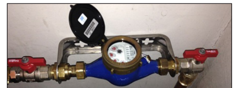
Konsolen sitter fastskruvad i väggen och stabiliserar rören.
